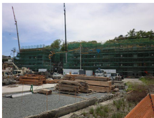
▲災害公営住宅の建設や道路建設、用地買収など復興業務は今後も続きます。気仙沼市内湾地区に建設中の災害公営住宅。
