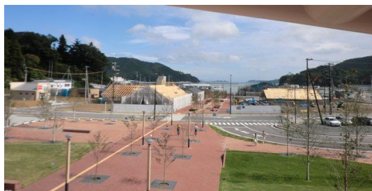
▲写真1：商店街の建設工事が進む駅前プロムナード。湾左手には女川魚市場や水産加工団地が並ぶ。
