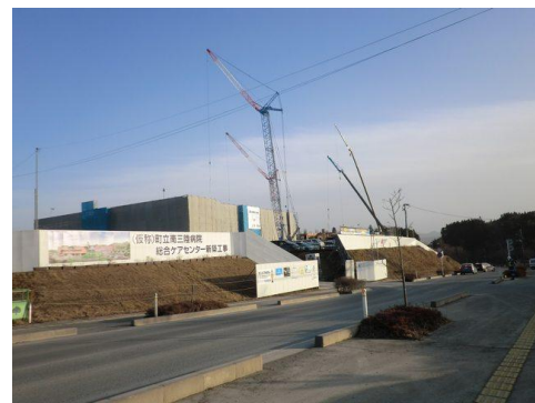
▲写真 2：2015 年秋の開院予定を目指し、工事が進む「(仮称) 町立南三陸病院・総合ケアセンター」
