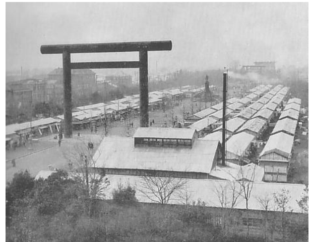
靖国神社に設置された仮設住宅
